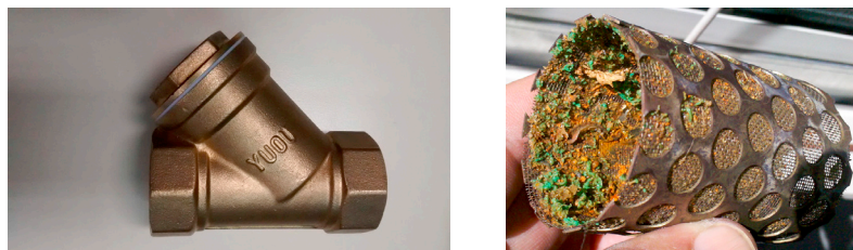
Figura 9. Filtro tipo "Y" e filtro tampado com sujeira
